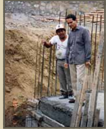
Padre Othmar mit dem Maurer und Vorarbeiter Carlos Cordova beim Bau des Heiligtums.
