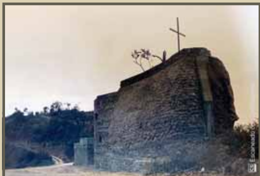
Der Rohbau des Heiligtums ist fertig, 1984
